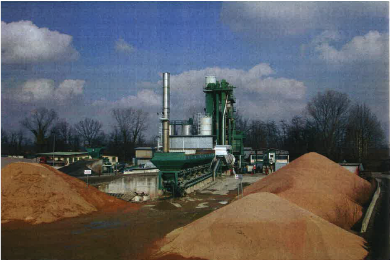
Figura 2: Impianto Ecoasfalti sito di Peschiera Borromeo
