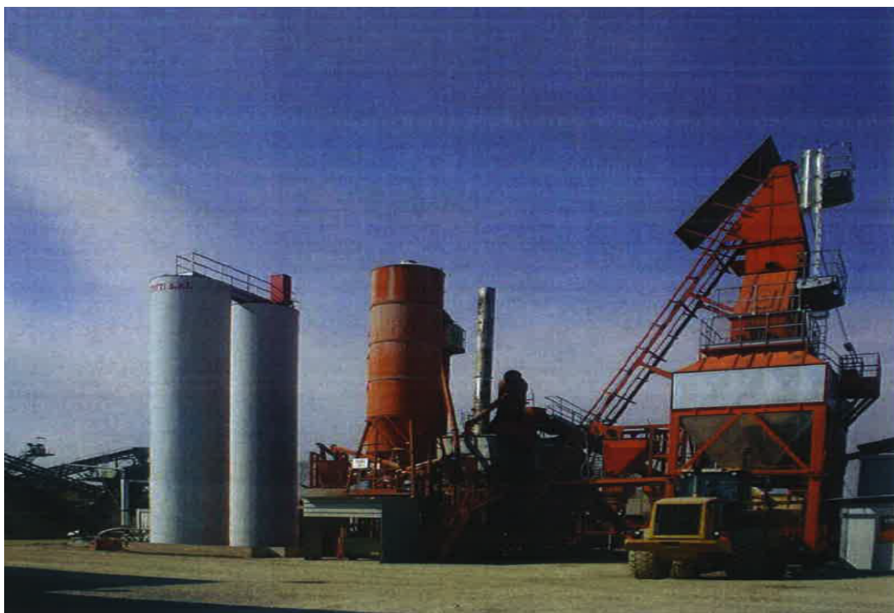
Figura 1: Impianto Ecoasfalti sito di Cusago
